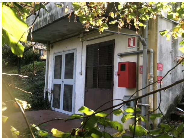
F Locale Caldaia
