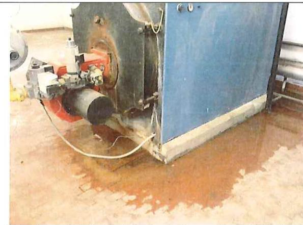
Figura 5 - perdite d'acqua dalla flangia di raccordo tra il bruciatore e la caldaia
