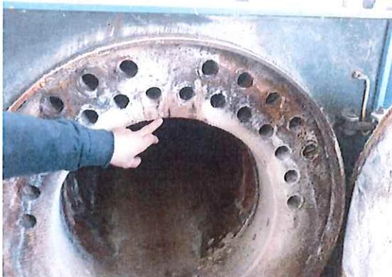
Figura 7 - presenza di cricche sulla flangia della caldaia
